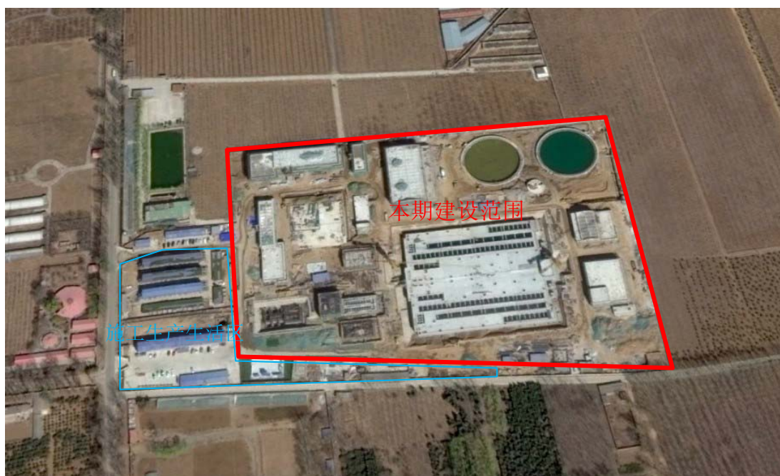
工程建设中期卫星遥感图（来源于 Google earth 2016 年 3 月拍摄）
