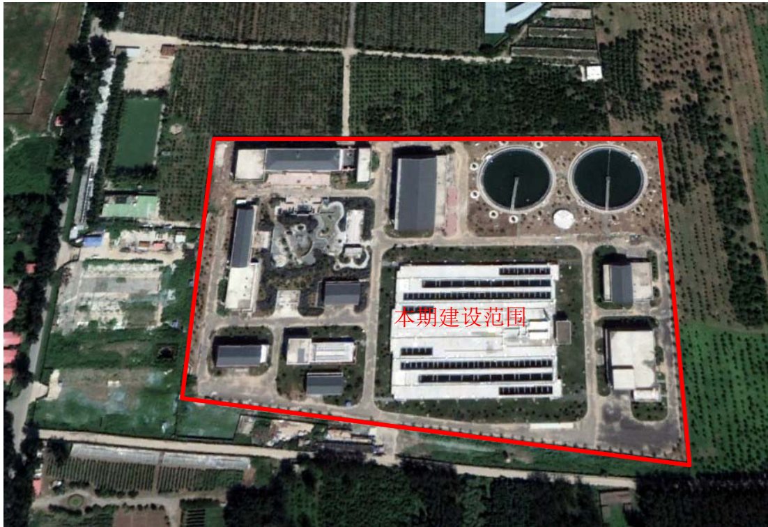
工程建设后期卫星遥感图（来源于 Google earth 2017 年 8 月拍摄）
